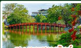
สะพานแสงอาทิตย์
