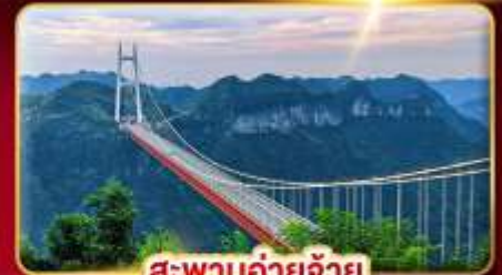
สะพานอ้ายจ้าย
